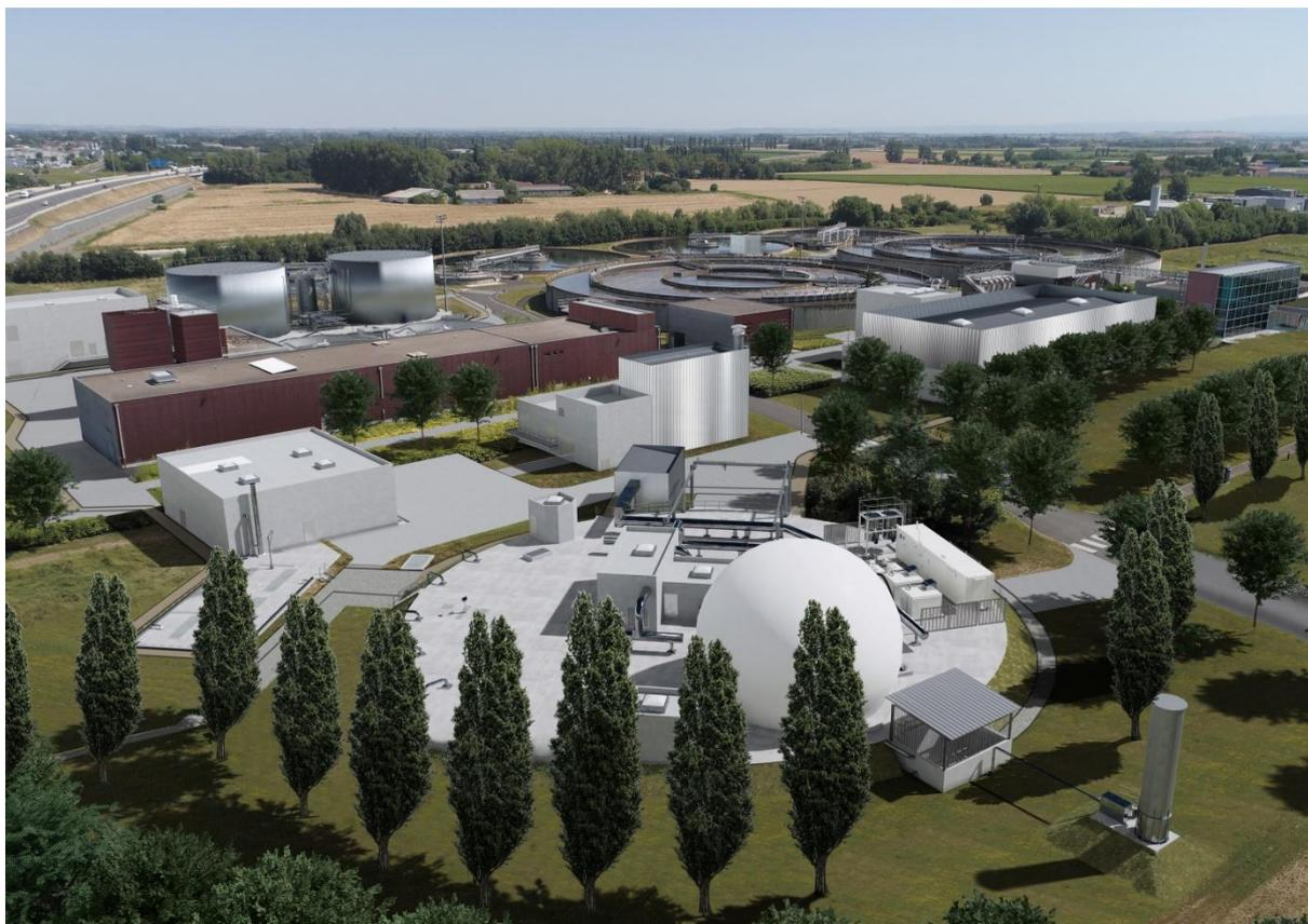
**Figure n°9. Vue en perspective des futures installations avec à droite le bâtiment du tamisage et de la décantation primaire**
